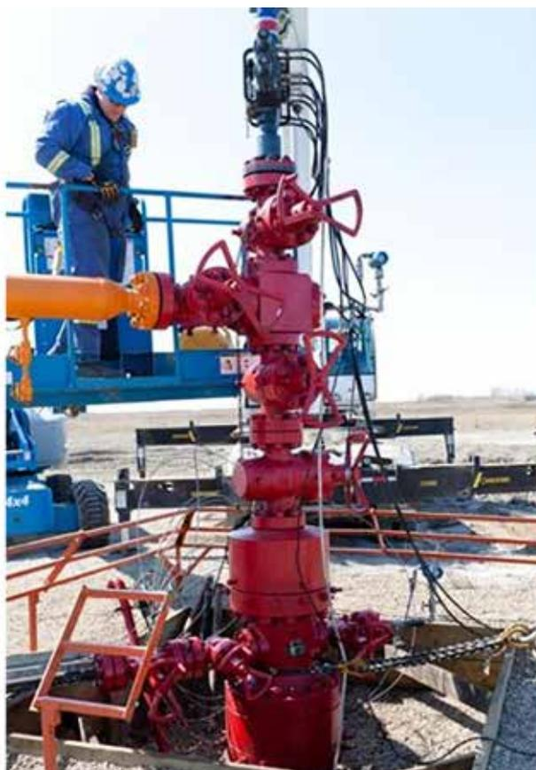
图片说明：安装过程中的 Aquistore 深度地质封存项目注入井 (资料来源：石油技术研究中心)
