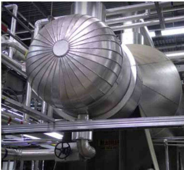
图片说明：萨斯喀电力尚德电站碳捕集测试设施内的釜式再沸器（萨斯喀电力供稿）
