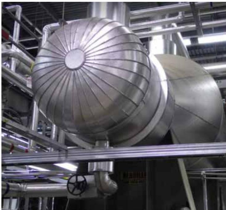
图片说明：萨斯喀电力尚德电站碳捕集测试设施内的釜式再沸器（萨斯喀电力供稿）
