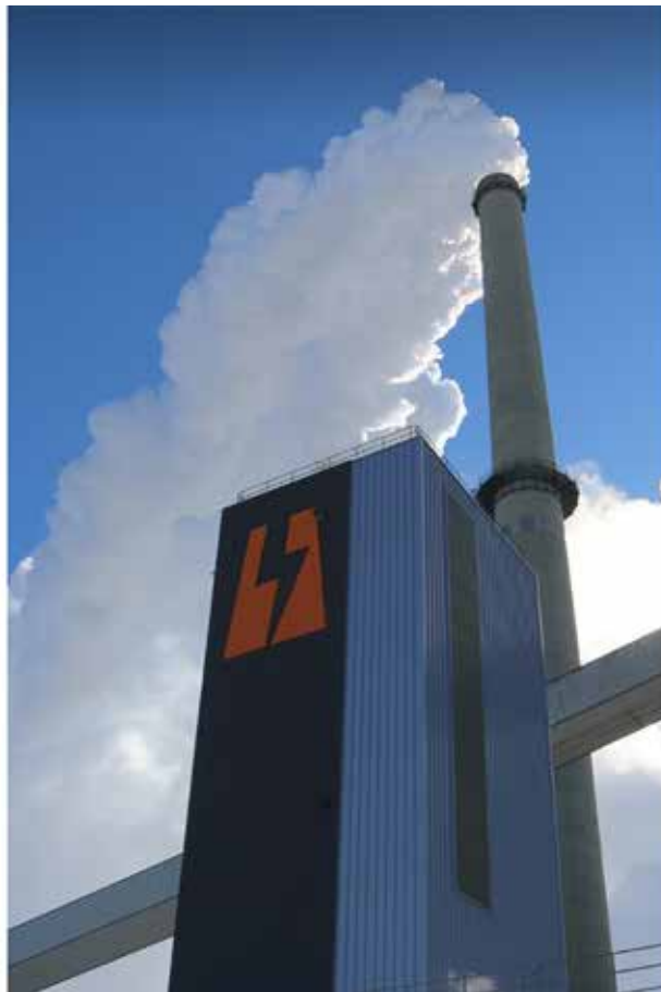
图片说明：碳捕集技术验证设施位于萨斯喀彻温省埃斯特湾市附近的萨斯喀电力集团尚德电站（萨斯喀电力公司供稿）
