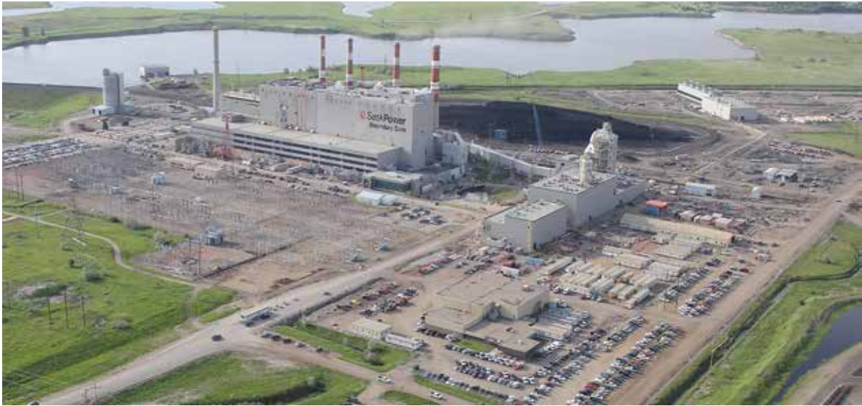
图片说明：位于萨斯喀彻温省埃斯特湾市附近的萨斯喀电力边界坝电站3号机组碳捕集设施鸟瞰（碳捕集利用与封存知识国际中心供稿）。
